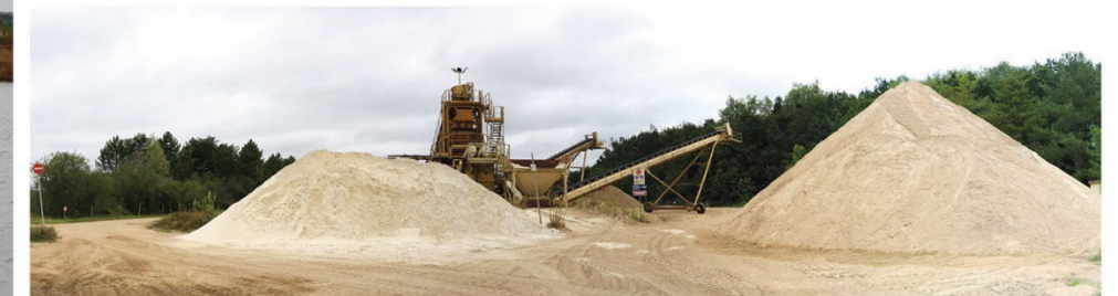
5 - La plate-forme de traitement est située au Nord de la carrière actuelle
