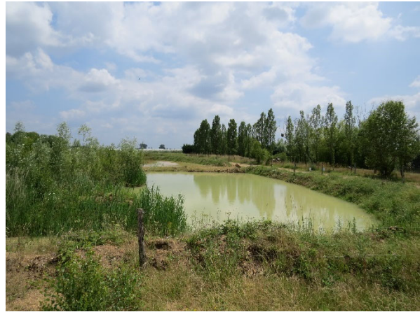
Les bassins de décantation du circuit de lavage
