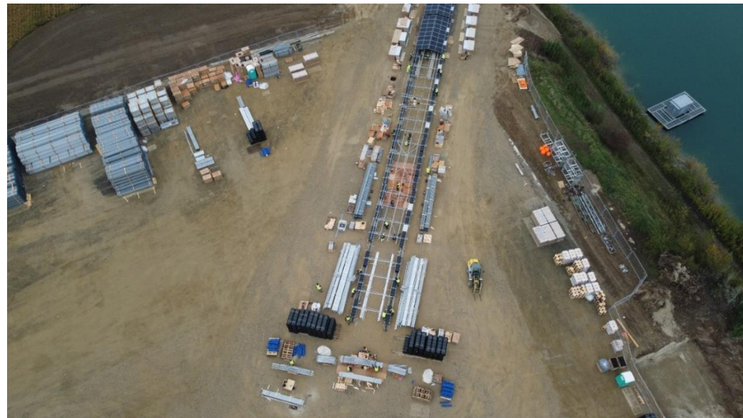
Figure 162 : Assemblage des bateaux solaires sur une rampe de lancement (source : BayWa r.e.)
