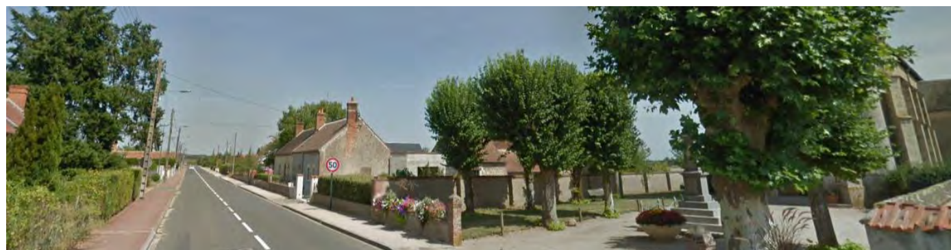
Photo 50 : Le centre-bourg de Bonnée au niveau de la place de l'église, sur la RD 961
