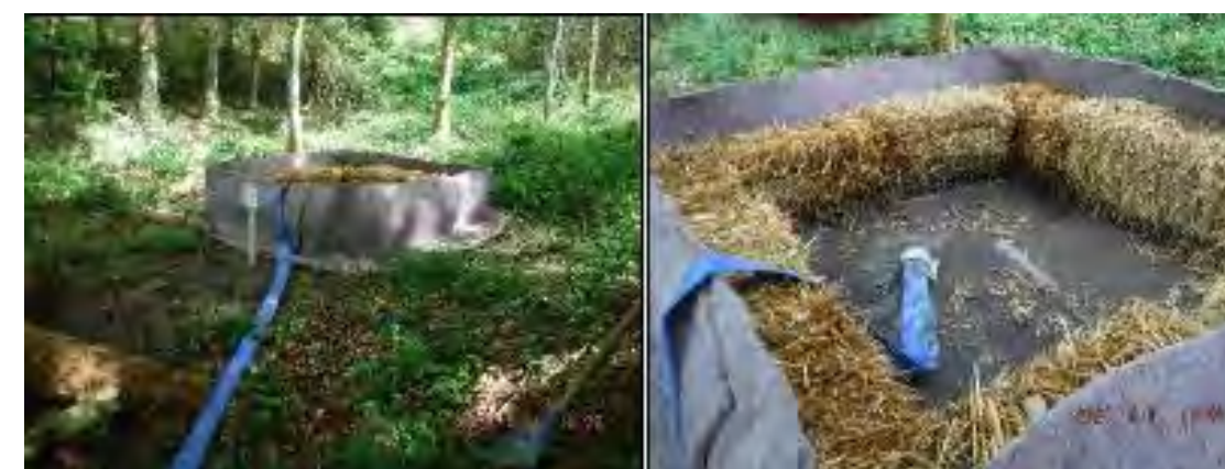
Photo 89 : exemple de bac de décantation équipé de filtre à paille pour la filtration des eaux turbides suite au terrassement.
