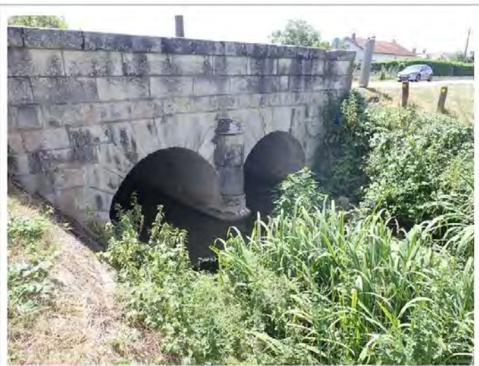
Exemple de pont à arches (lieu-dit le pont de Bonnée)
