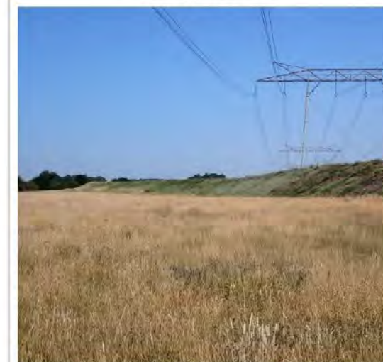
Vue depuis l'aval
