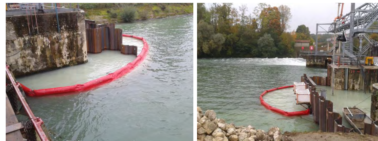
Photo 88 : Mise en place de barrage anti-MES
