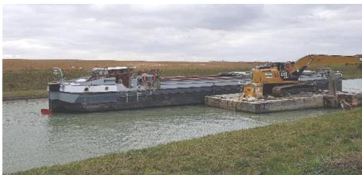
Figure 6 : Illustration d'un dragage mécanique d'une pelle sur ponton (source : VNF)
