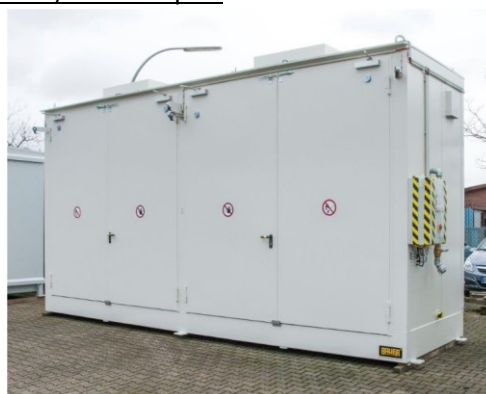
Figure 29: Photographie d'un container pour le stockage de batteries critiques
