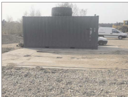
Aire étanche dédiée aux sous-traitants à proximité du container sur rétention contenant la cuve de carburant
