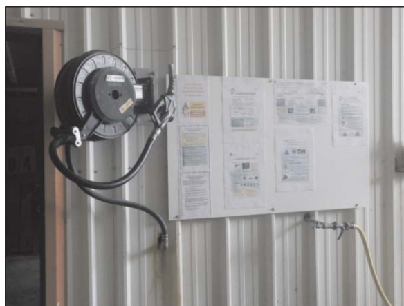
Pompe de distribution de carburant et consignes et procédure à suivre
