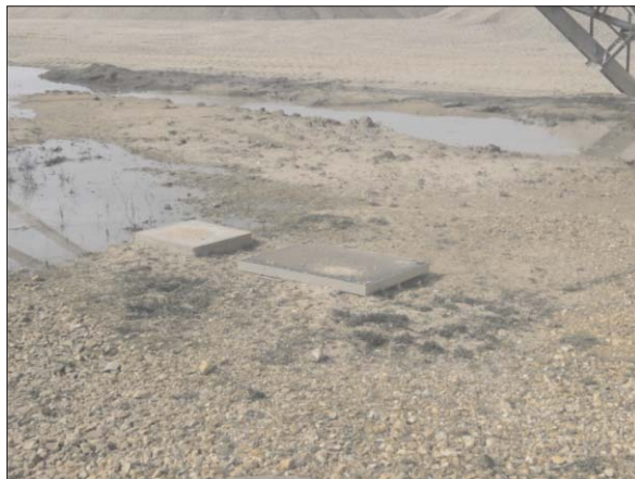
Débourbeur/déshuileur relié à l'aire étanche de l'atelier
