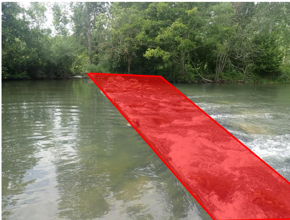
Figure 16 : Effacement du seuil de Conflans-sur-Loing
