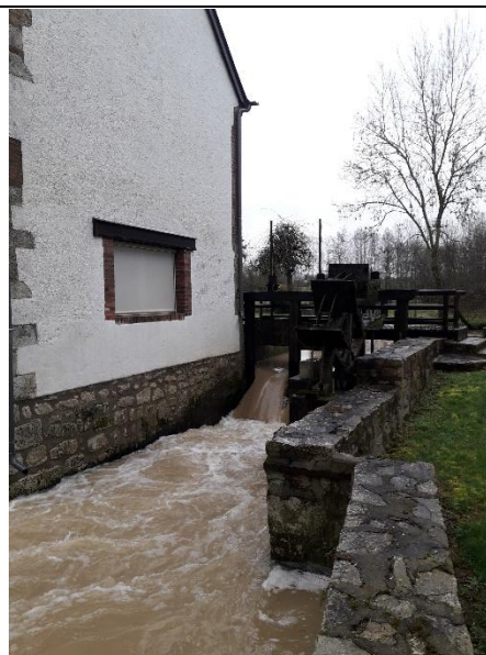
2 : 3 vannes du moulin
