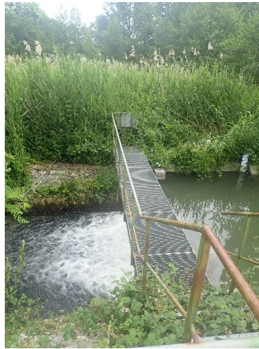
Figure 52 : Photographie de la passerelle piétonne au-dessus du canal d'amené (SEGI – juin 2020)
