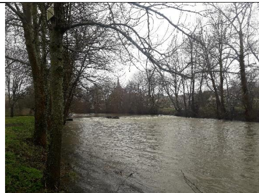
Vue vers l'amont (aval seuil)
