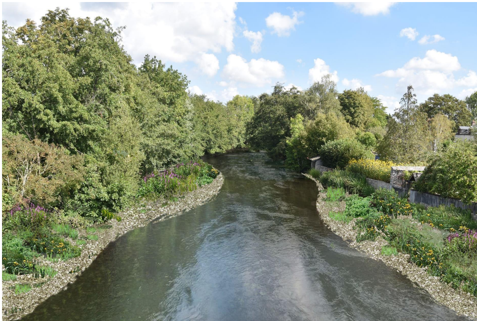
Figure 123 : Photomontage des aménagements prévus sur le site de Montbouy (banquette uniquement en rive gauche à la suite d'évolutions en phase PRO)
