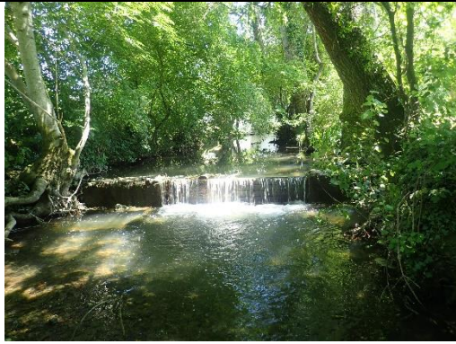
3 : Seuil transversal bétonné en aval du moulin
