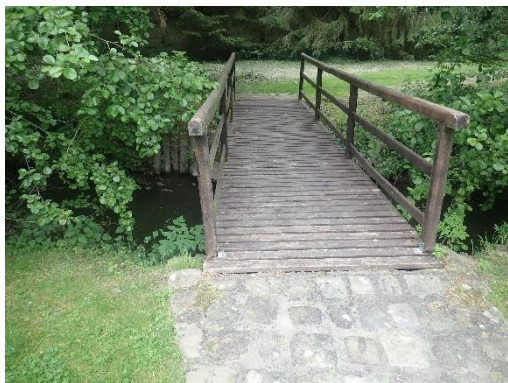
Passerelle piétonne sur le bras de décharge
