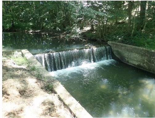
Figure 99 : Déversoir régulant le bras de décharge (ROE64506) – Moulin Bondon
