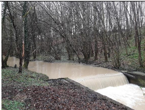
5 : Bras de décharge avec déversoir et radier
