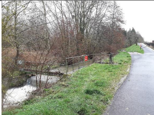
3 : Canal d'aménée au canal de Briare avec son seuil
