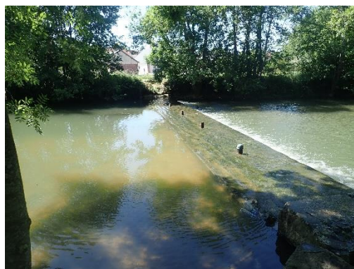
Figure 102 : Seuil de Montbouy
