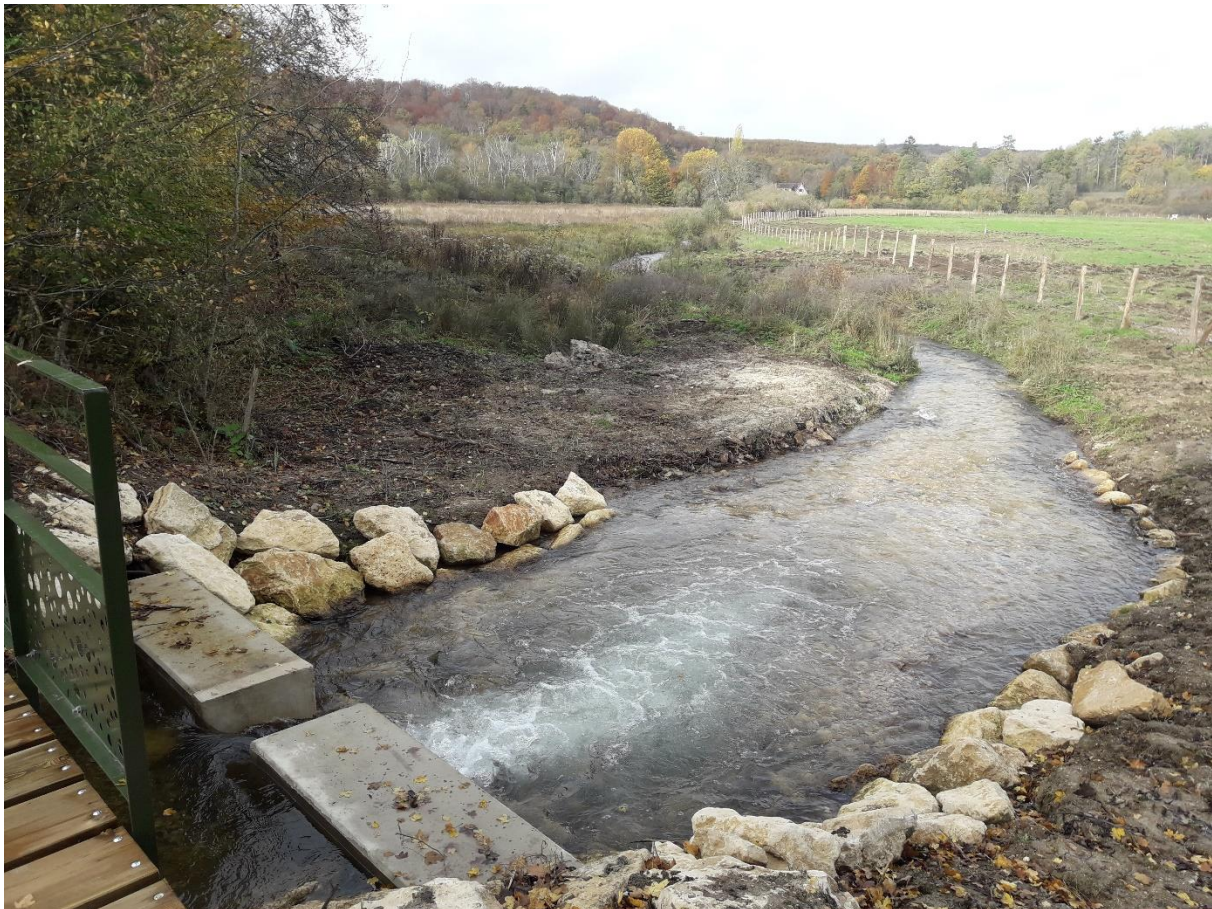
Figure 21 : Aménagement de l'amont du seuil de répartition
