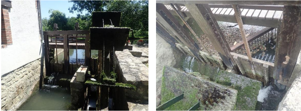
Figure 100 : Vannes sur le bras usinier – Moulin Bondon
