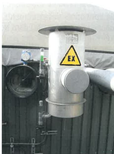
Exemple de soupape de sécurité. Source : Bio-Nrj.
