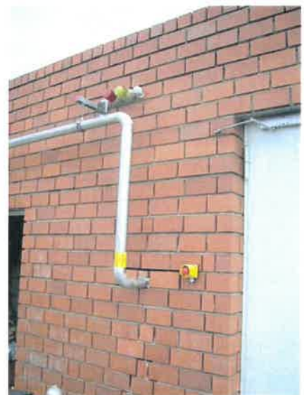
Dispositif « coup de poing ». Source : Bio-Nrj.
