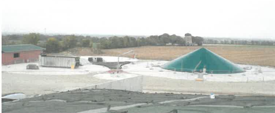
Installation de méthanisation agricole avec système « tank in tank » (post digesteur imbriqué dans le digesteur) enterré. Source : Biogas Hochreiter GmbH - A.E.B. - Méthafrance.
