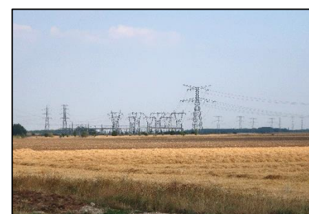
Poste source Source : L'Artifex 2018
