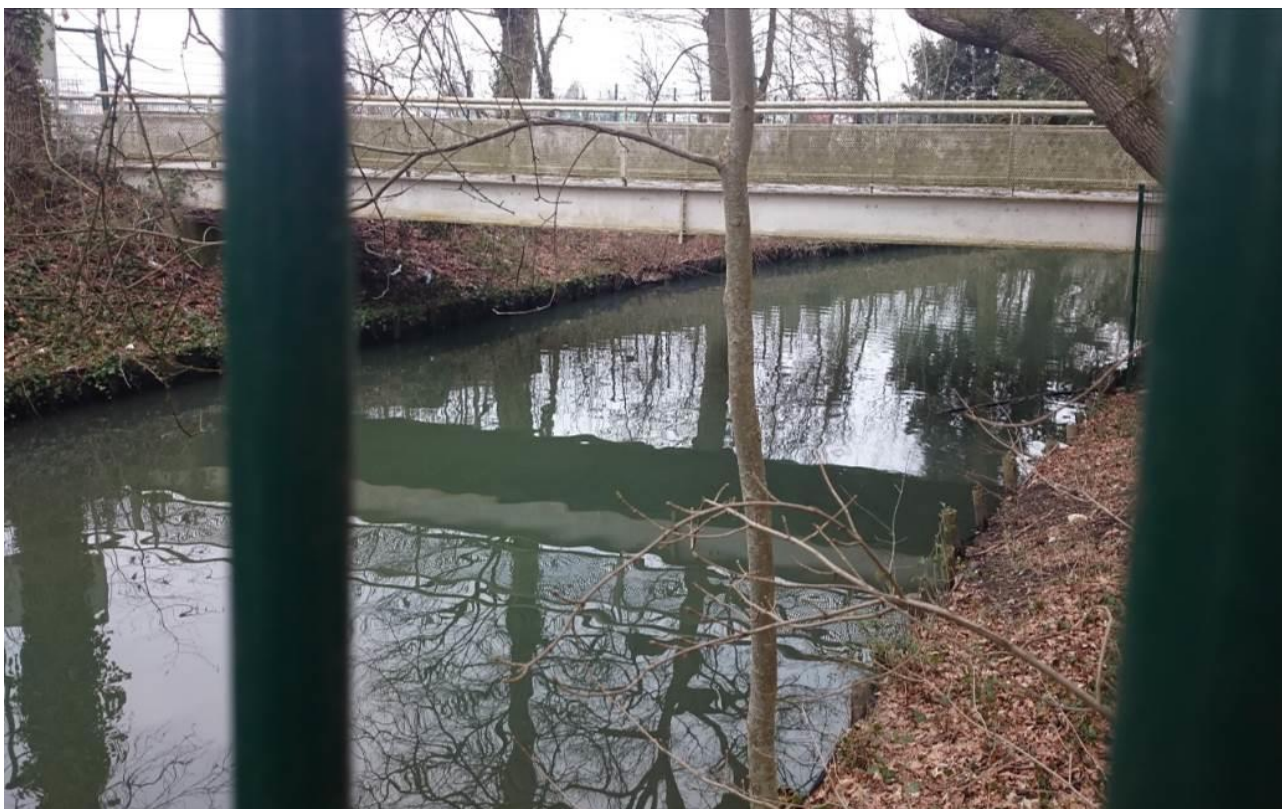
Photographie 2 : Vue du Bras des Montées au niveau de la passerelle d'accès au Parc des Expositions (11/03/2016)
