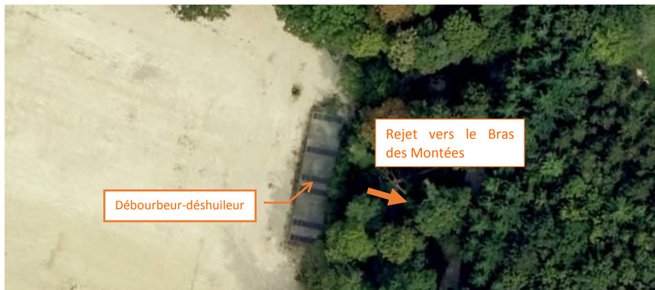
Photographie 12 : Débourbeur-déshuileur du Parc des expositions d'Orléans (Source : Google Earth)
