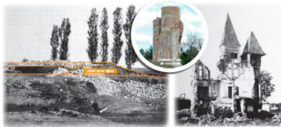
Échec de la digue en 1900 près d'Orléans
