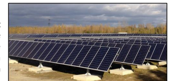
Figure 5 : Types de fondation - semelle béton
