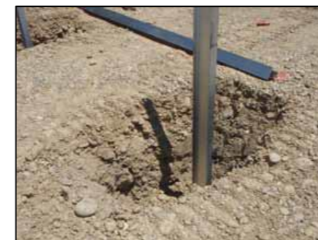
Figure 4 : Types de fondation - pieux battus
