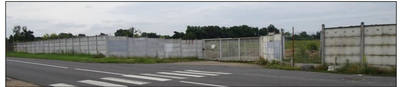
Figure 10 : Photographie du mur existant sur le site d'Amilly (Source : NCA Environnement)
