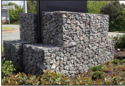
Figure 6 : Exemple de muret en gabion (Source : TCS Geotechnics)
