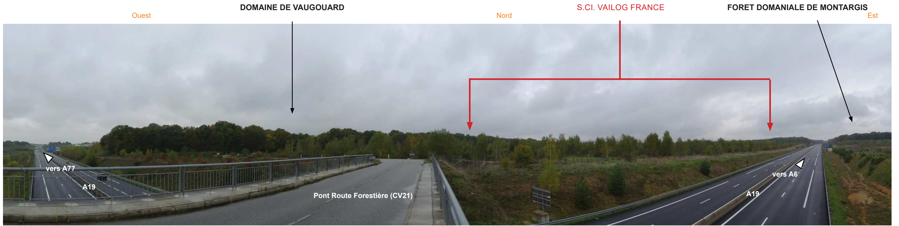
1 - VUE DEPUIS LE PONT AU-DESSUS DE L'A19 VERS LE NORD.
