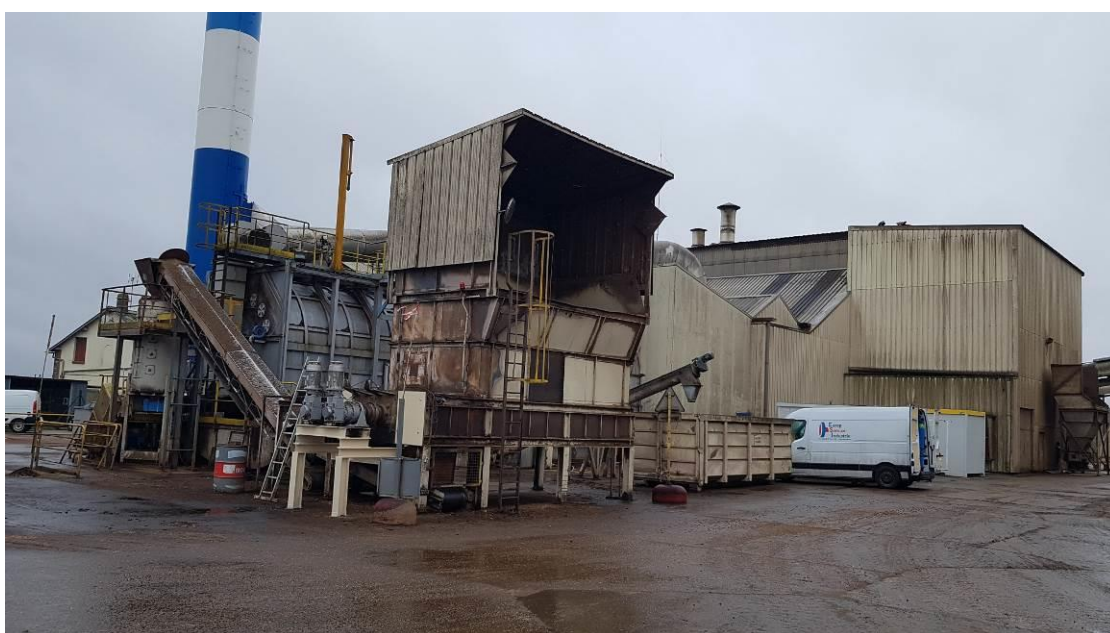
VUE DE LA ZONE D'IMPLANTATION DE LA TROISIEME LIGNE DE DESHYDRATATION
