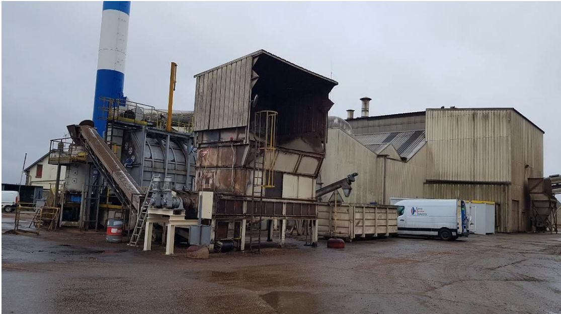
VUE DE LA ZONE D'IMPLANTATION DE LA TROISIEME LIGNE DE DESHYDRATATION
