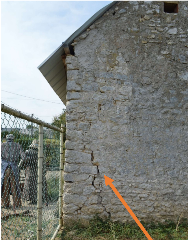
Exemples de fissures sur habitations liées aux mouvements de terrain liés aux vibrations
