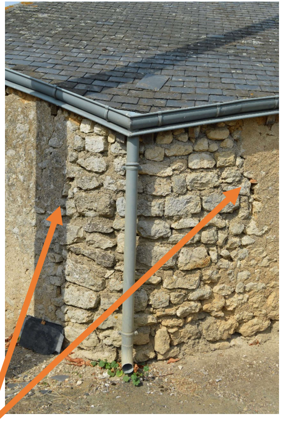
Exemples de fissures sur habitations liées aux mouvements de terrain liés aux vibrations
