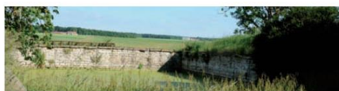
Les résurgences du plateau karstique et des mares aménagées près des villages sont délimitées par des murets de pierre sèche.
