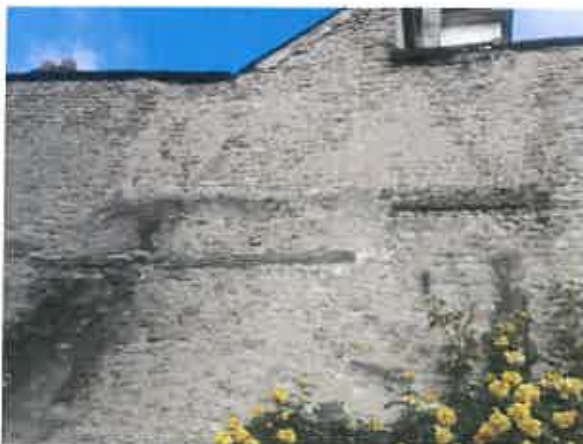
Vestige de linteau en bois pris dans le mur
