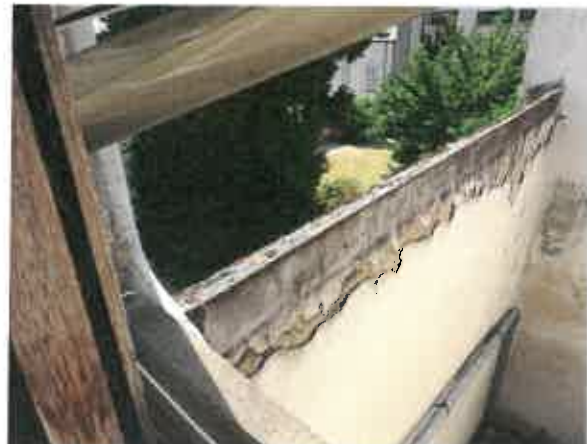
Vue du mur depuis l'ouest
