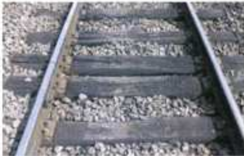
Rails courts sur traverses bois
