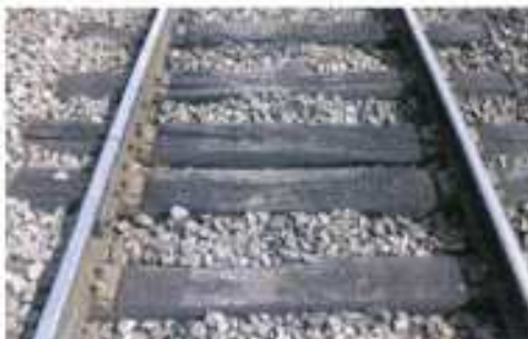
Rails courts sur traverses bois
