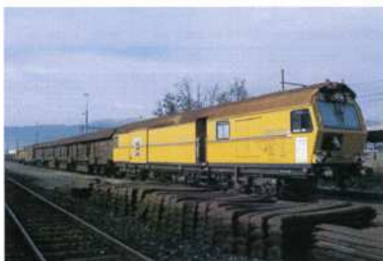
Train meuleur de rails (Scheuchzer S.A.)
