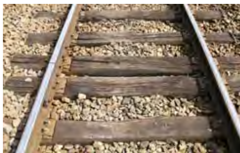
Rails courts sur traverses bois
