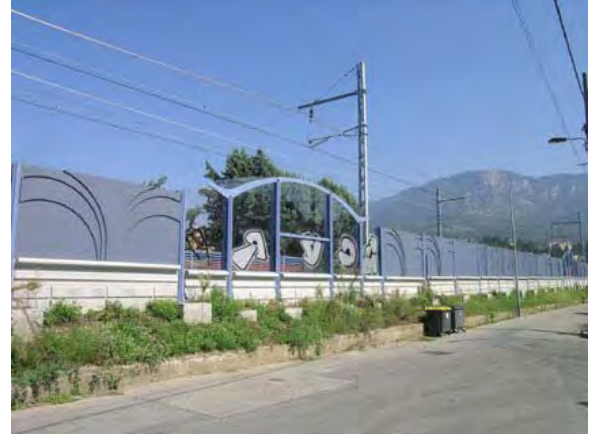
Exemples d'écrans acoustiques à Aix Les Bains
