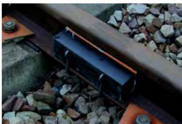
Exemples d'absorbeurs sur rail (Corus et Socitec)
