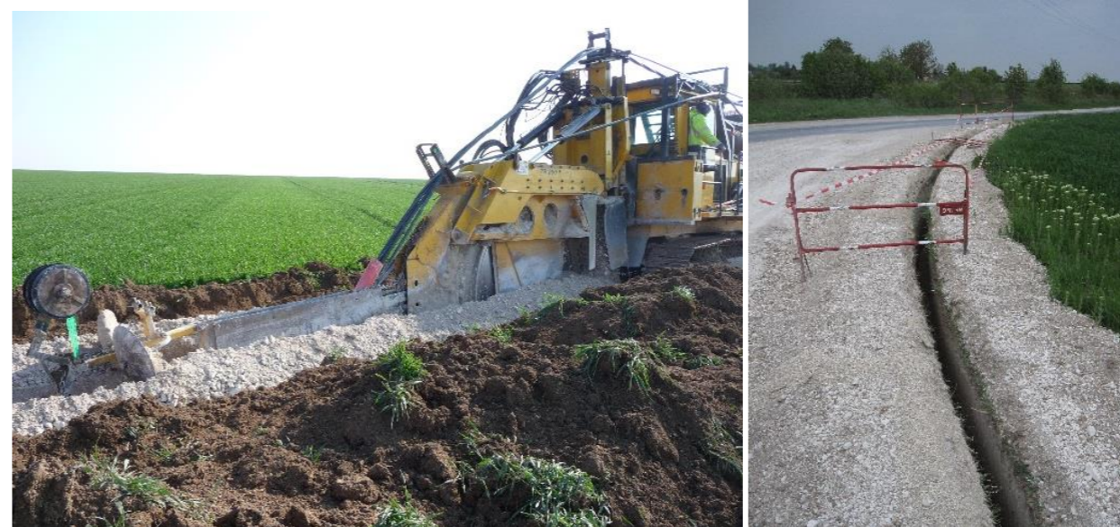
Figure 25 : Exemple de tranchées réalisées – Total Energies
