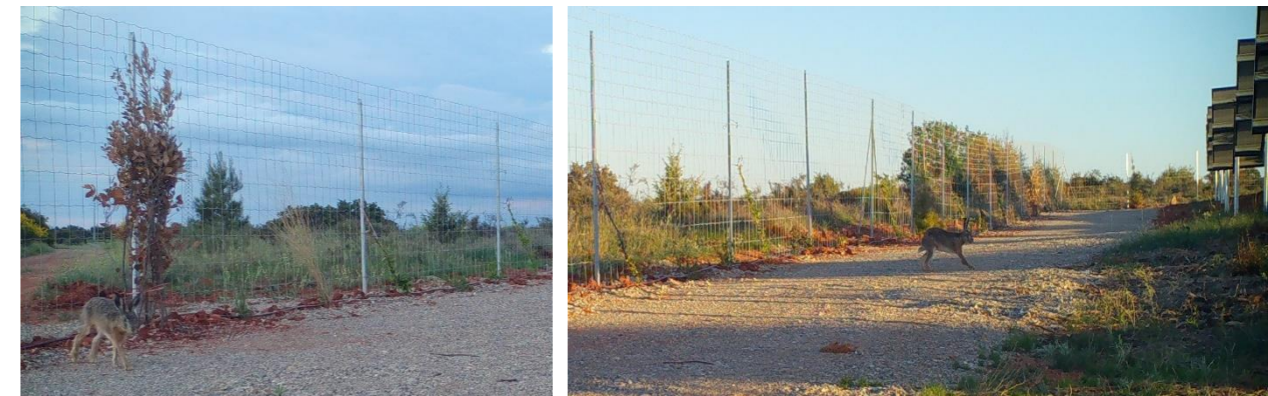
Figure 21 : Exemple de clôture à grosse maille d'enceinte d'une centrale solaire photovoltaïque au sol
