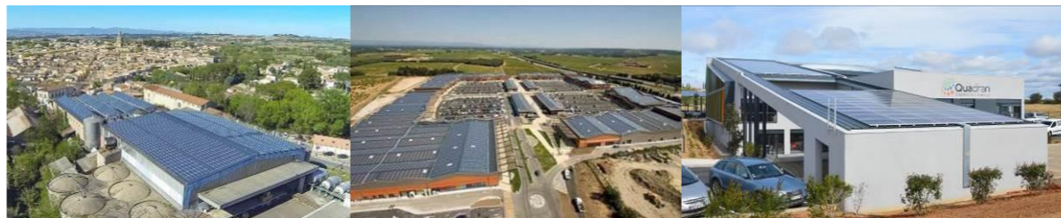
Figure 9 : Exemples de centrales photovoltaïques en toiture (Source : TotalEnergies)
