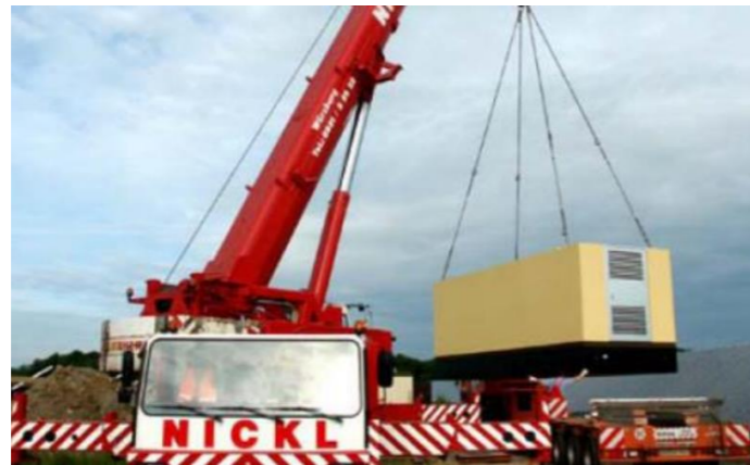
Figure 24 : Installation du poste de transformation - TotalEnergies
