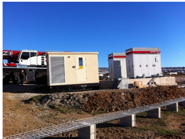
Figure 20 : Mise en place de locaux techniques
