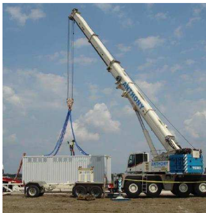
Photo 46 : Engin utilisé pour la pose des postes onduleurs (source : Engie Green)
