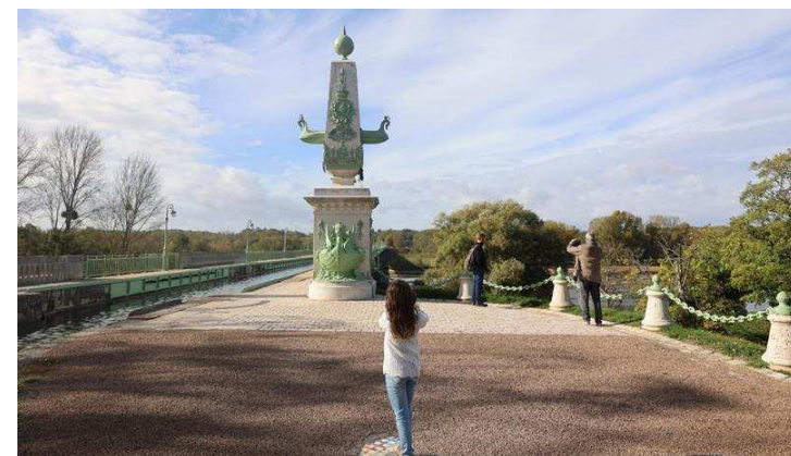
Figure 120 : Pont canal de Briare, un lieu touristique (L'Atelier Mathilde Martin)
