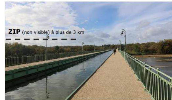
Figure 119 : Pont canal de Briare par rapport à la ZIP (L'Atelier Mathilde Martin)
