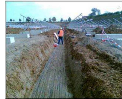
Figure 33 : Exemple de tranchée (Source : ENGIE Green)
