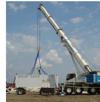
Figure 34 : Engin utilisé pour la pose des postes onduleurs (Source : ENGIE Green)
