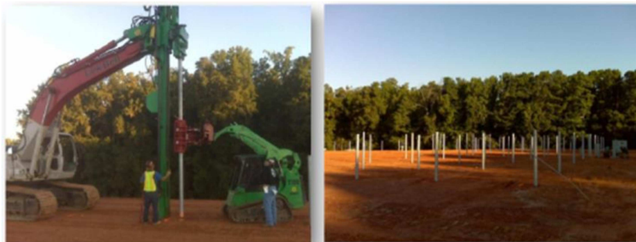
Figure 19 : Installations de pieux Source : ENGIE Green)
