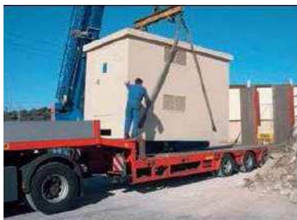
Figure 36 : Déchargement d'un poste électrique (Source : ENGIE Green)
