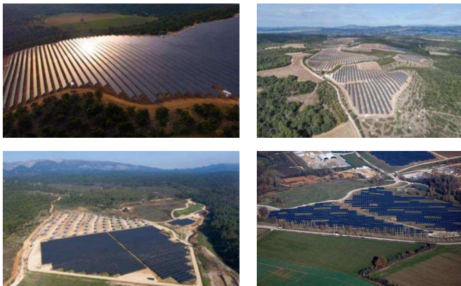
Figure 12 : Exemples de parc photovoltaïque ENGIE Green
