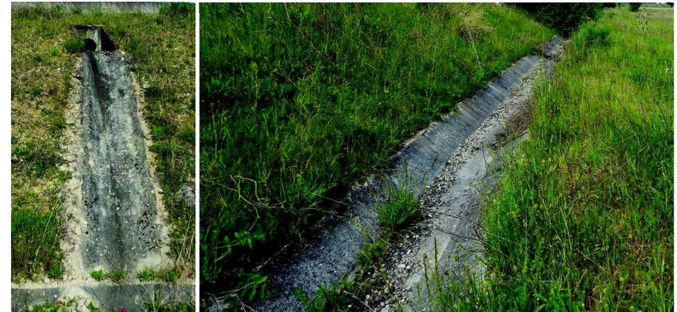
Illustrations d'une descente d'eau à gauche et du fossé en « V » bétonné de 50 cm à droite
