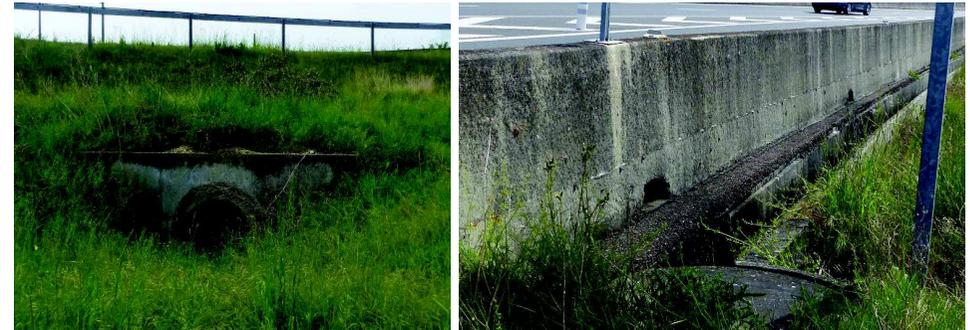
Illustrations de la buse de 1000 mm de diamètre à gauche et du fossé en « U » 30x30 à droite
