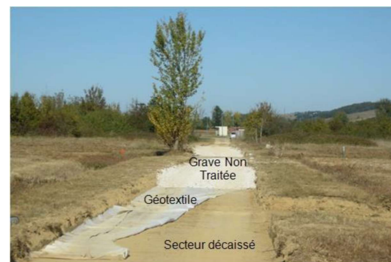
Mise en place d'une voie engins (lourde)
