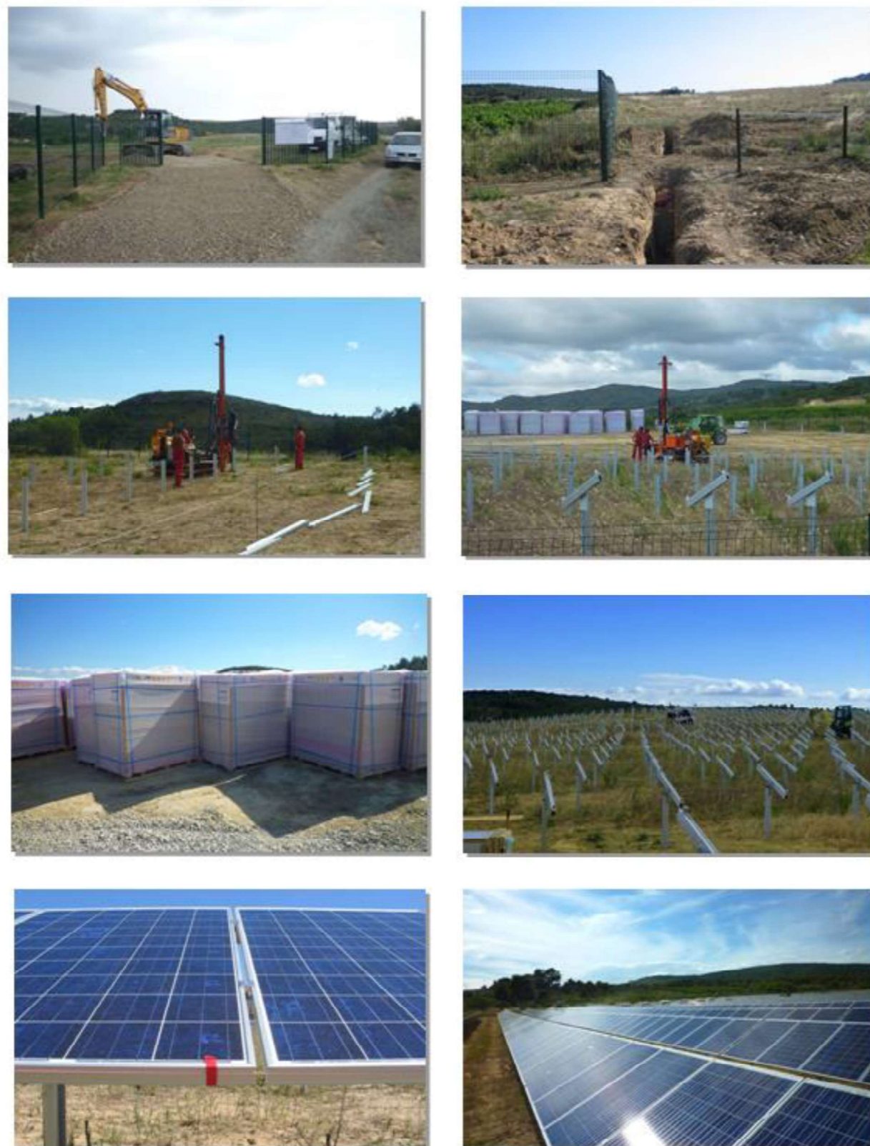
Présentation des différentes étapes du chantier (Source : LUXEL)
