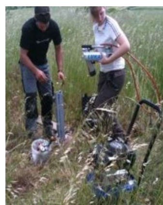
Test de résistance à l'arrachage des pieux
