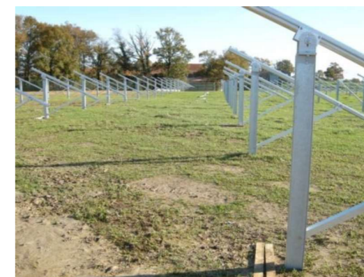
Structures prêtes à recevoir des modules
