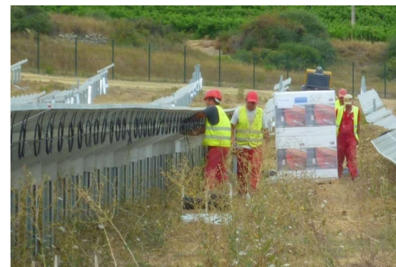
Câblage et interconnexion des modules photovoltaïques
