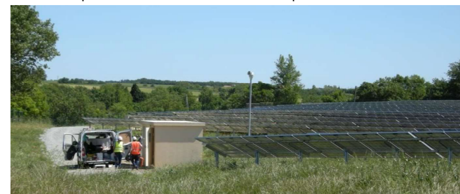
Opération de maintenance
