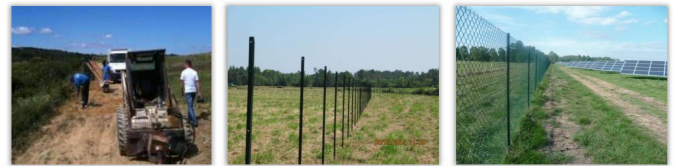
Mise en place de la clôture : pose des ancres, des piquets et du maillage
