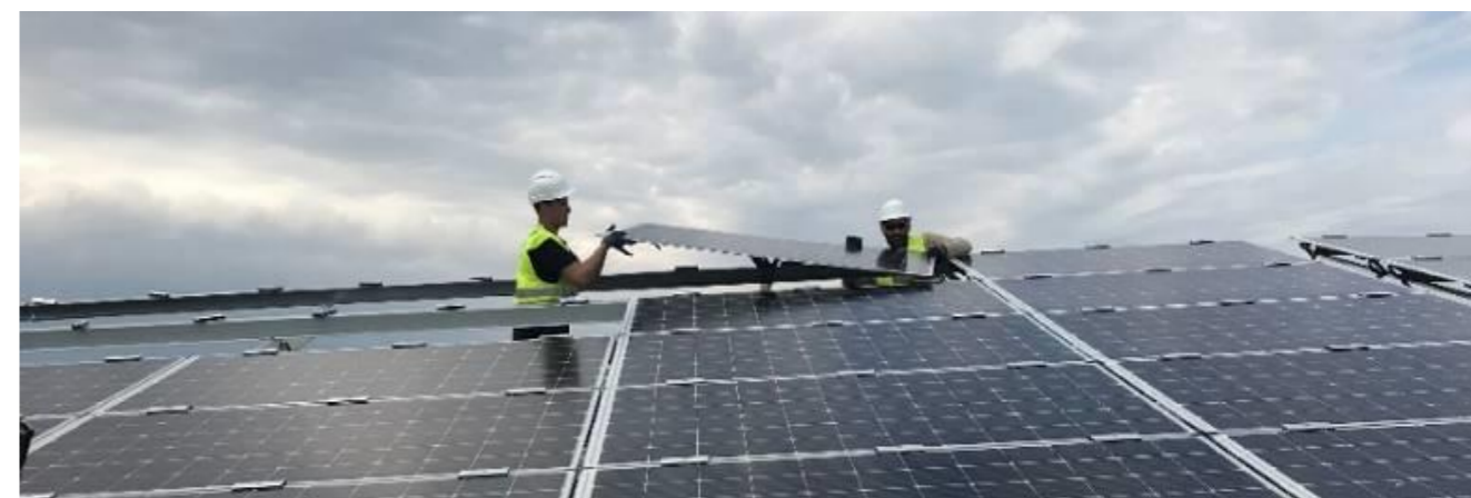
Figure 34 : Pose des modules (Source : EDF Renouvelables)
