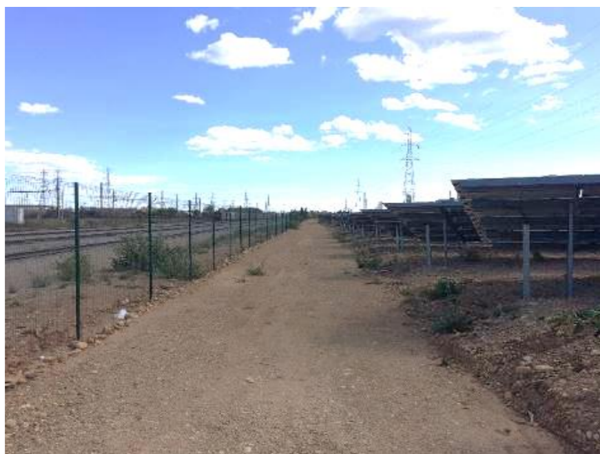
Figure 24 : Exemple de piste périphérique (Source : EDF Renouvelables)
