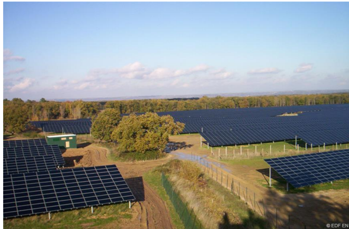
Figure 11 : Fauche différenciée sur la centrale solaire de Narbonne (11) (photo du haut) et corridor écologique préservé en fin de chantier au sein de la centrale de Boulac (31) (photo du bas) Source : EDF Renouvelables
