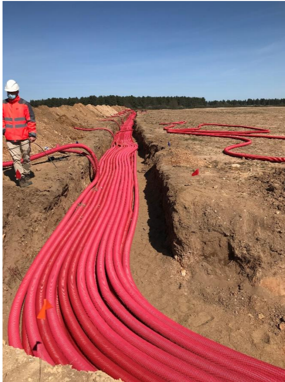
Figure 35 : Exemple de réalisation de tranchées du raccordement interne (Source : EDF Renouvelables)
