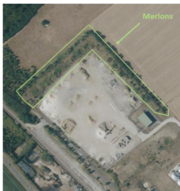
Figure 31 : Merlons végétalisés au sein du site
