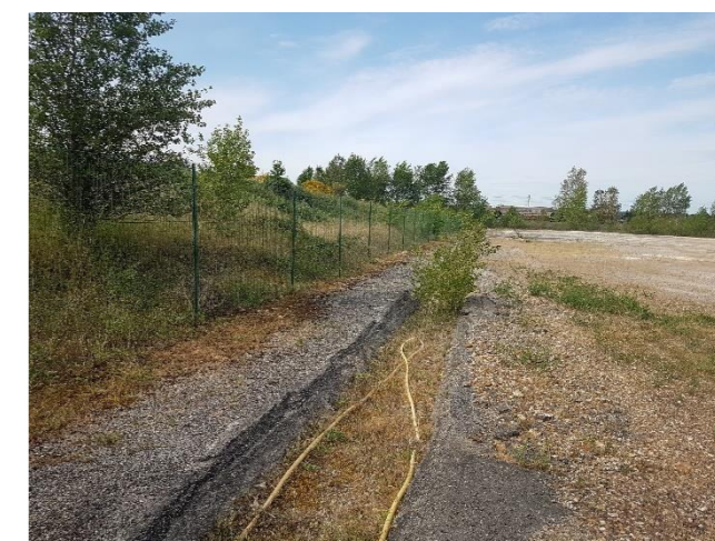
Photo 5 : Fossé le long de la plateforme
