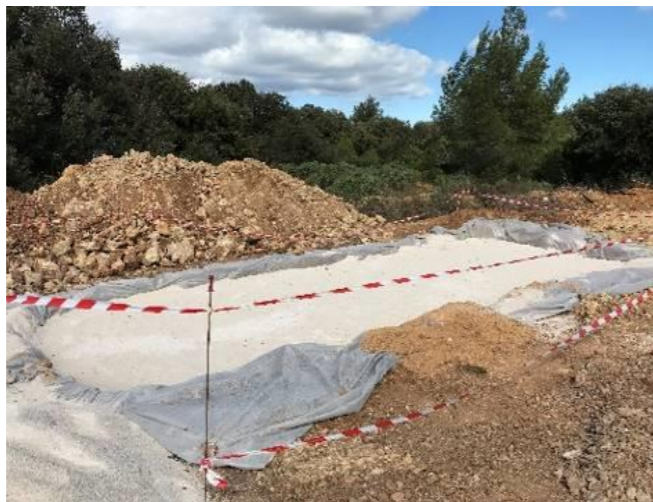
Figure 36 : Fouille préparée pour la pose d'un poste de conversion/transformation (Source : EDF Renouvelables)
