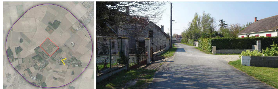
Figure 143 : Photographie de la traversée d'une zone d'habitations (Crédit photo : NCA Environnement)
