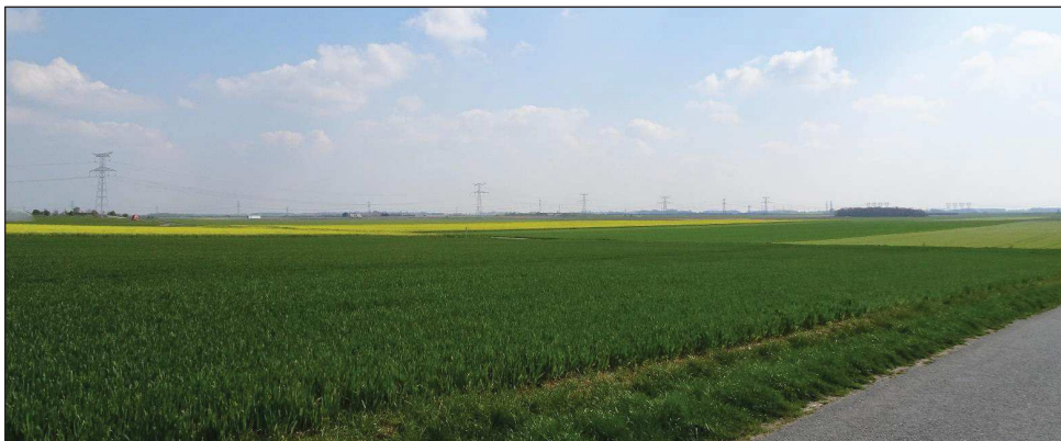
Figure 125 : Photographie des lignes à haute tension qui marquent les plaines du territoire d'étude (Crédit photo : NCA Environnement)
