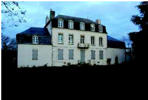
Façade ouest du Château de la Borde Source : CORYDALIS
