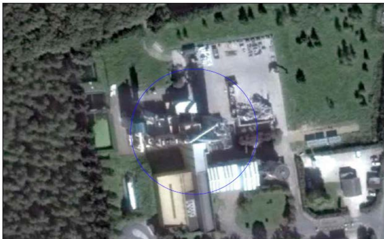
PhD 2.C : Dispersion limitée de propane dans le bâtiment four pendant 1 min et une explosion
